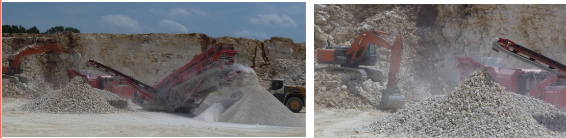
▲ Exemple d'émissions de poussières au niveau d'une installation
